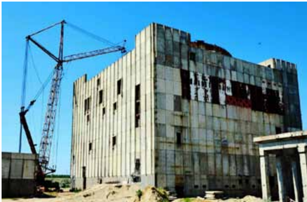
Рис.4 Здание энергоблока КАЭС, 2012 г.
